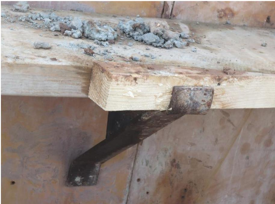
Après avoir examiné les instructions des fabricants, on a remarqué qu'au moins un fabricant ne permet pas l'usage de « raidisseurs » comme consoles d'échafaudage. Les raidisseurs ne doivent être utilisés que pour raidir les murs de coffrage et ne doivent pas servir comme plates-formes de travail; étant donné qu'il s'agirait d'une infraction à l'alinéa 9(2)a) de la *Loi sur l'hygiène et la sécurité au travail*, selon lequel :
